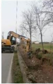
Lavori in via Baroni
