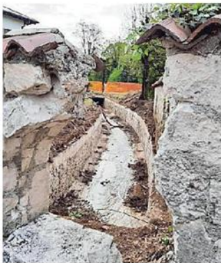
Un'immagine dei lavori
