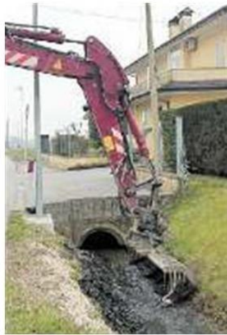
PULIZIA FOSSI Un escavatore toglie il fango dalla canaletta
