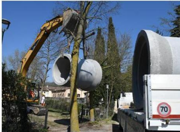
Lavori in corso lungo il Progno FOTO PECORA
