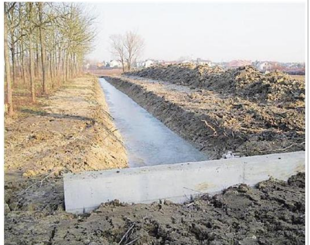
I lavori del consorzio di bonifica Acque Risorgive a Martellago
