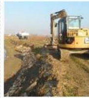
Lavori sui canali di scolo
