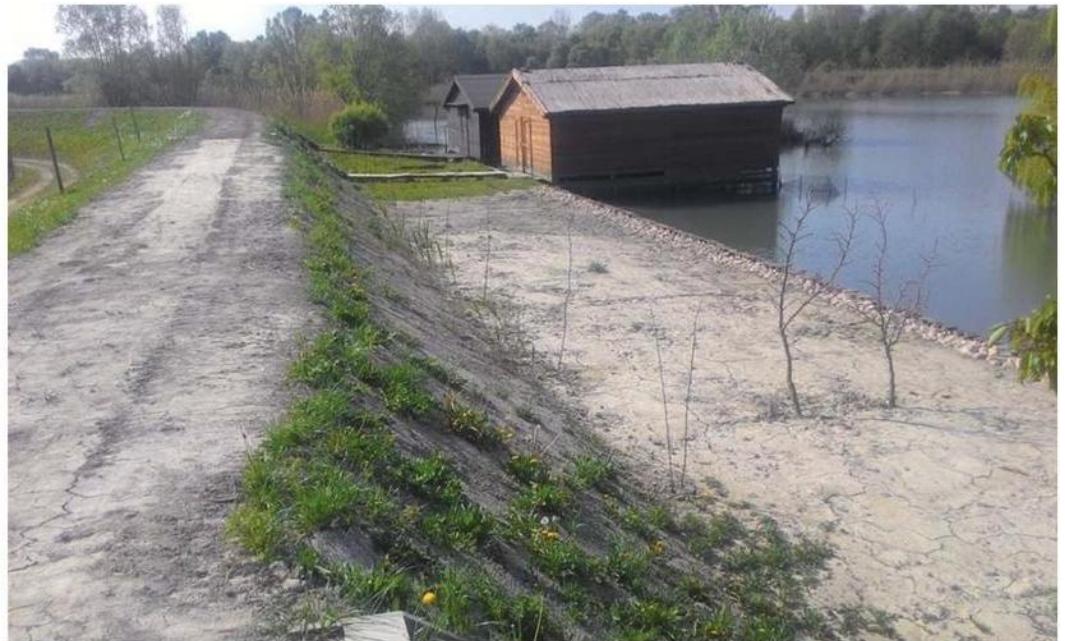
L'argine sinistro del canale a Sindacale
