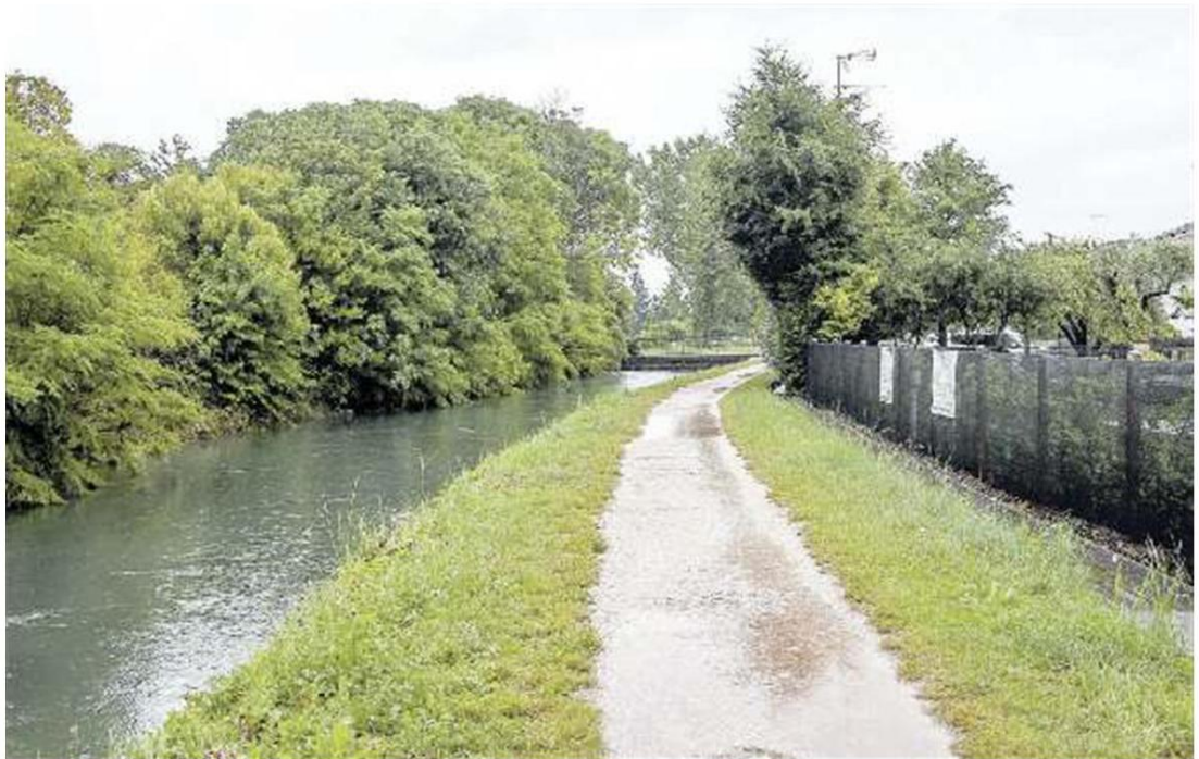
L'OSSERVATO SPECIALE Un'immagine del canale Caerano che mercoledì sera è straripato inondando le case vicine (NuoveTecniche/BORTOLANZA)
