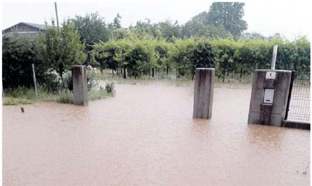
VIA ERIZZO Un'immagine dell'allagamento che ha costretto la polizia locale a chiudere per mezz'ora la strada per precauzione
