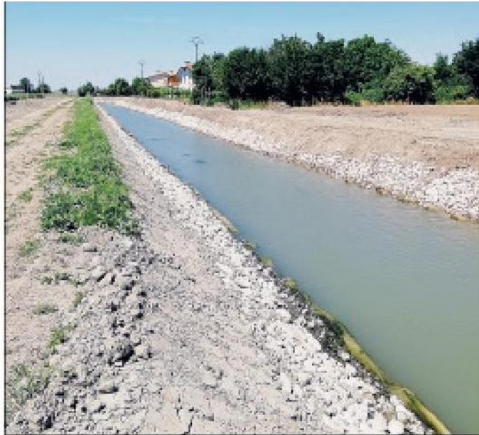
Un profondo intervento di sistemazione al canale Buniolo
