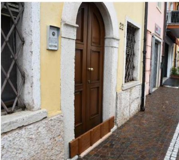
Paratia a un portone di via Bixio a Villafranca per evitare l'allagamento durante il temporale
