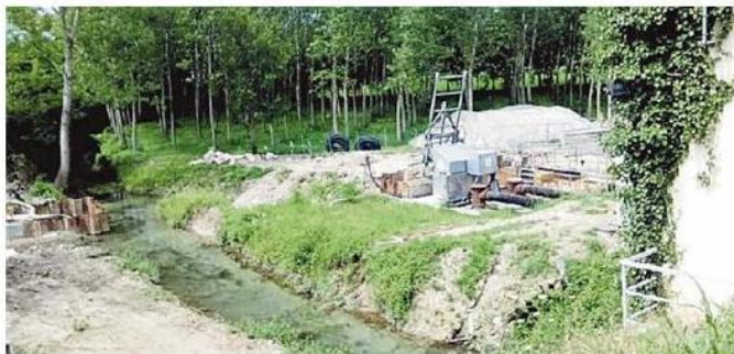
Un intervento in corso contro gli allagamenti a San Michele
