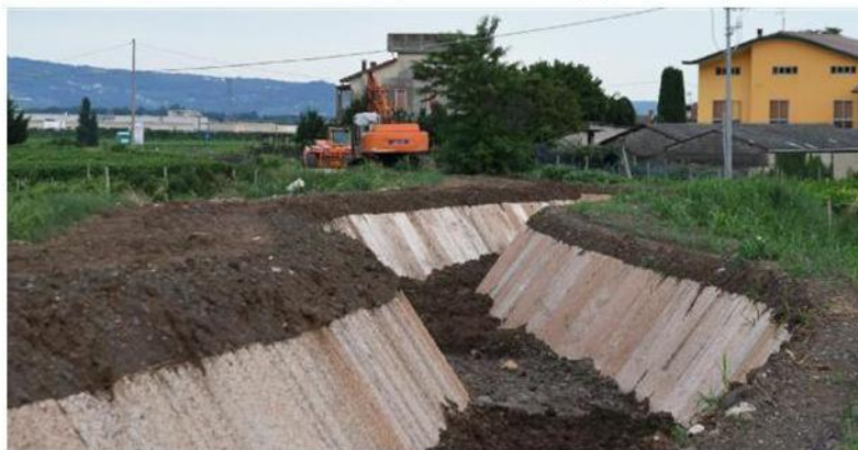
Un mezzo meccanico all'opera per dotare le sponde del Rio delle Carbonare delle lastre di pietra naturale
