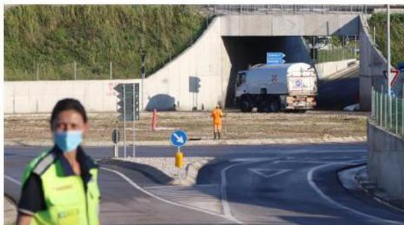
La rotatoria con il sottopasso della SPV: si stanno studiando soluzioni anti allagamenti. FOT. CISCATO
