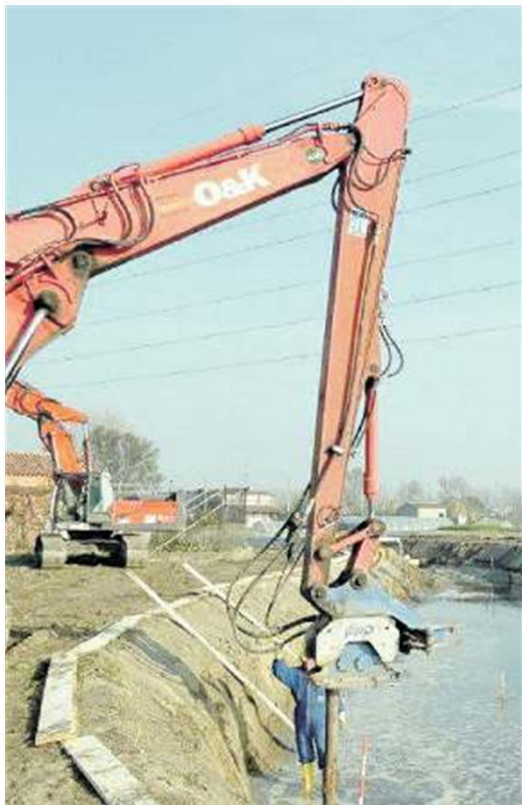
PIANO ANTI-ALLAGAMENTO Arriva dopo anni di attesa il canale Carpanedo-Sabbioni. In alto il sindaco di Maserà Gabriele Volponi
