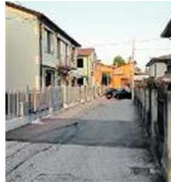
VIABILITÀ Traffico modificato per il cantiere in via Costa
