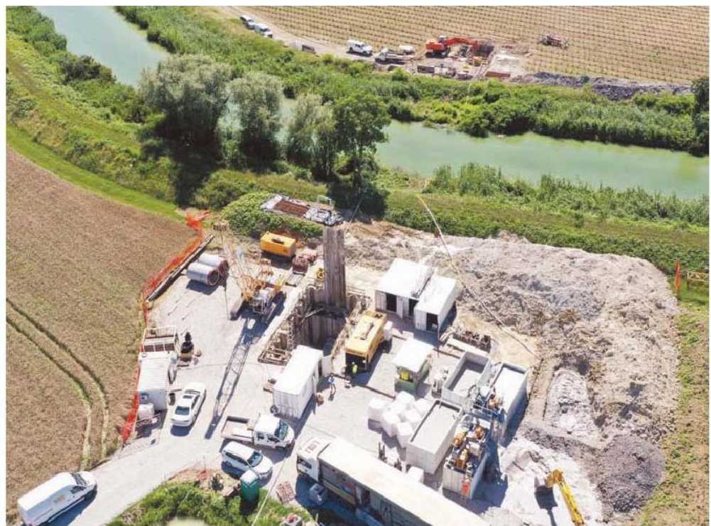
Il cantiere sul sottopassante di Loncon
