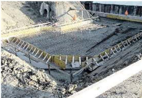
BONIFICA Tra i lavori, il nuovo ponte sostegno Bordin all'origine dello scolo Marina e lo scavo del Busi Destro
