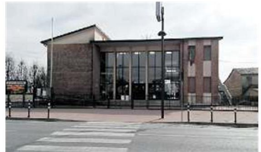
RISCALDAMENTO Da alcuni giorni è in funzione la nuova centrale termica a condensazione nella scuola materna di Rustega
