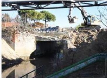
La demolizione del vecchio ponte pericolante
