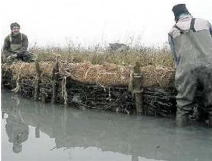
**SALVAGUARDIA I lavori di conterminazione delle barene sottoposte al rischio di erosione dalle correnti**
