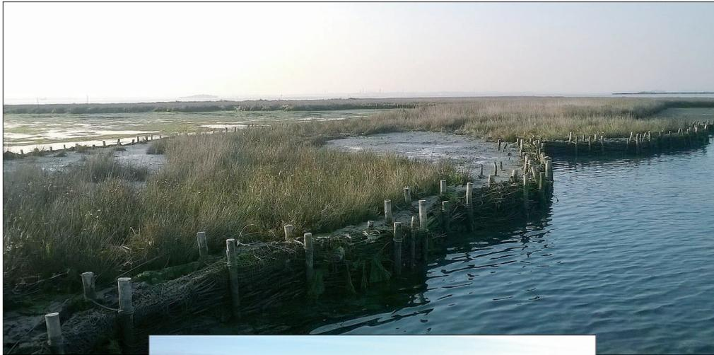
Senza pontoni né draghe, ma con sistemi soft sono stati ripescati i sedimenti usciti con la risacca e ripositionati sulla superficie delle barene
