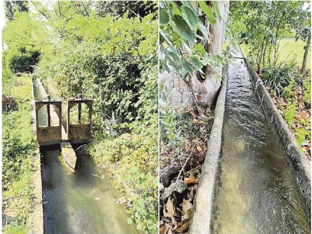
Due tipiche canalette in cemento che da anni vedono nelle nostre campagne: spariranno tutte
