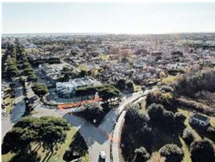
SAN MICHELE Il piano d'azione di una delle zone interessate dai lavori di queste settimane
