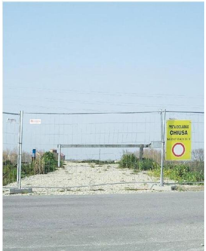
L'area dell'argine sul quale verrà realizzata la bretella nord a Bovolenta
