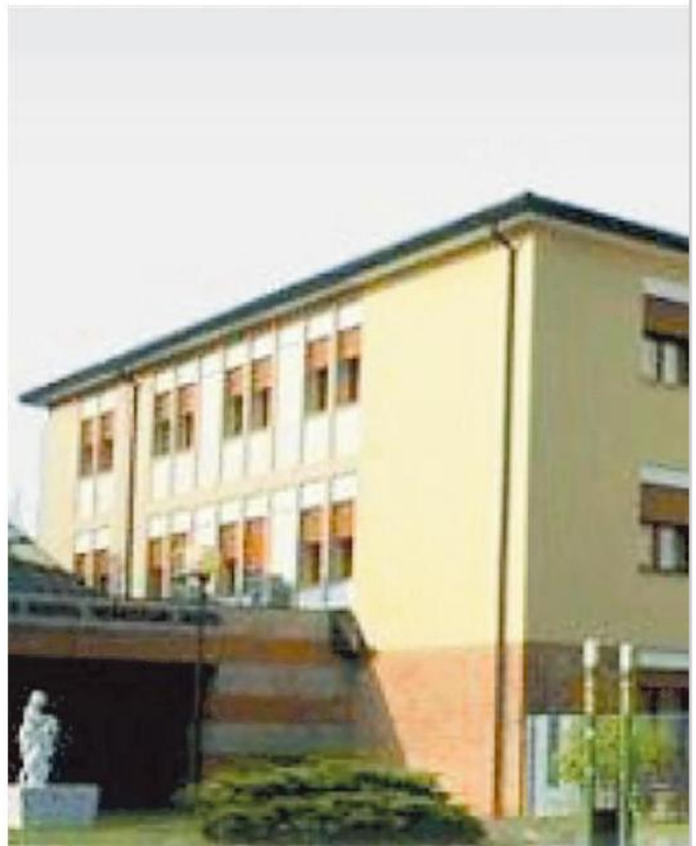
La sede del Consorzio di bonifica Brenta a Cittadella
