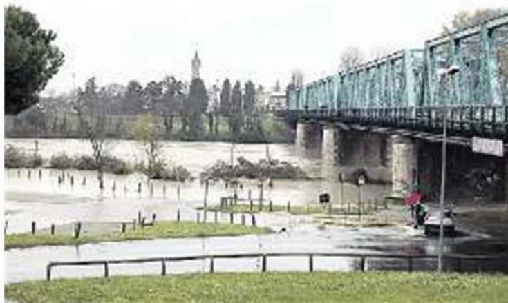
SUL PIAVE Allagamenti nella golena sotto il ponte
