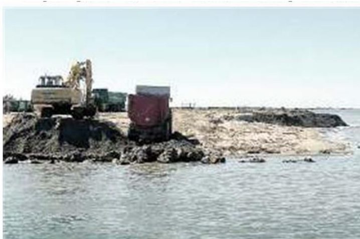
PORTO TOLLE Gli interventi in corso contro l'interrimento
