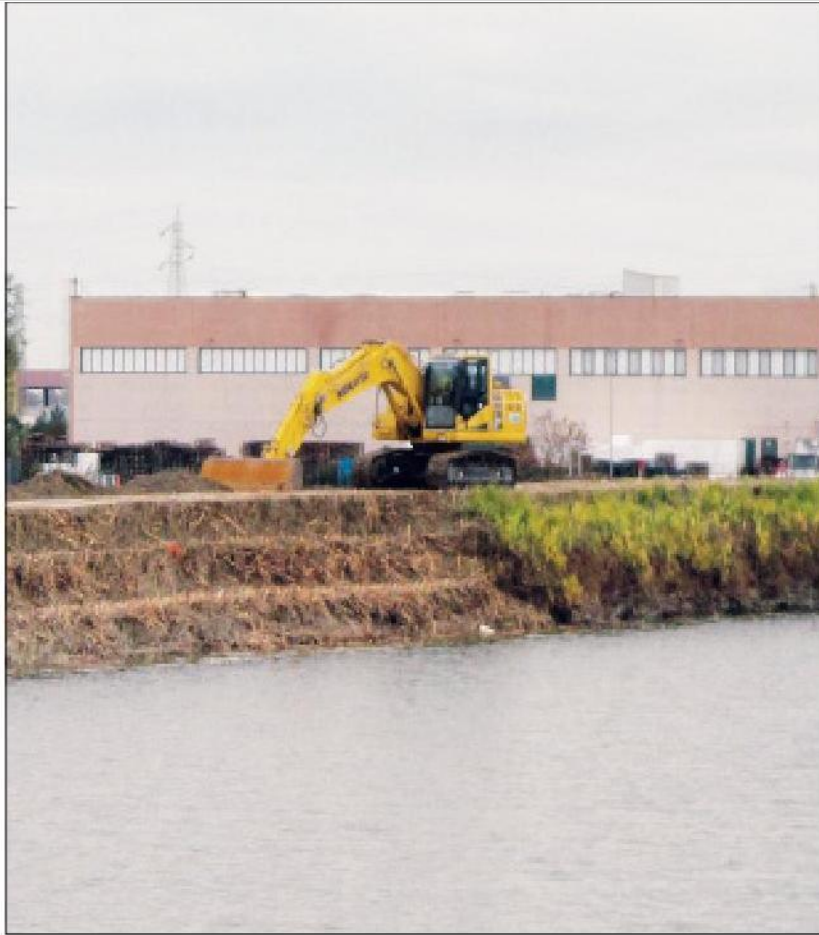
I lavori in corso
