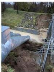
L'intervento sulla Caveggiara
