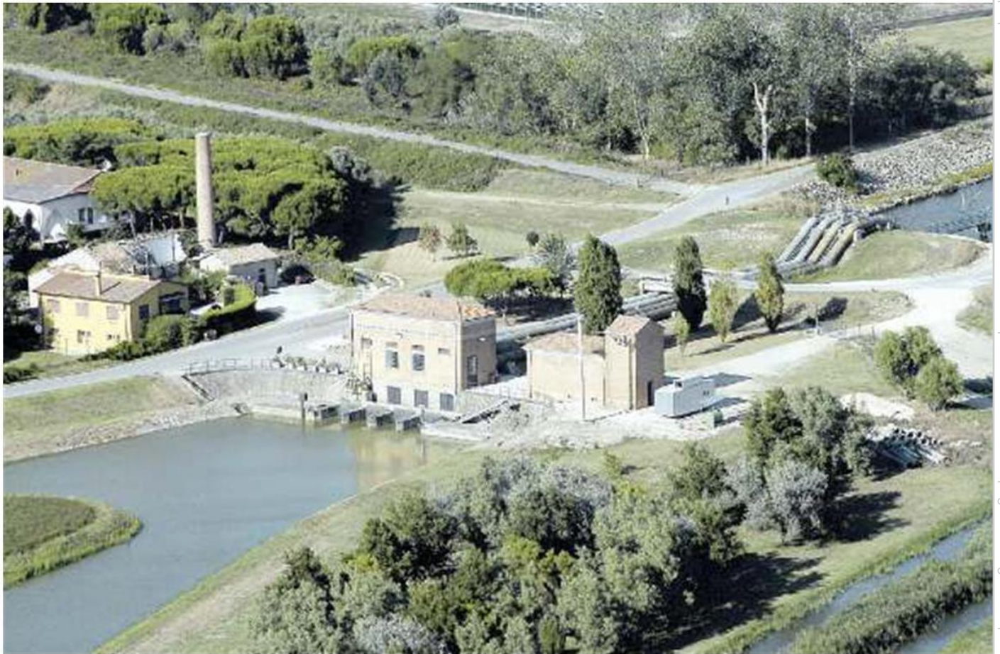
SALVAGUARDIA IDRAULICA Le idrovore non solo devono regimentare le acque, ma operare anche per gli effetti della subsidenza
