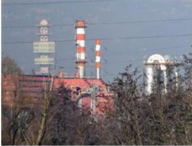
L'impianto di Ca' del Bue
