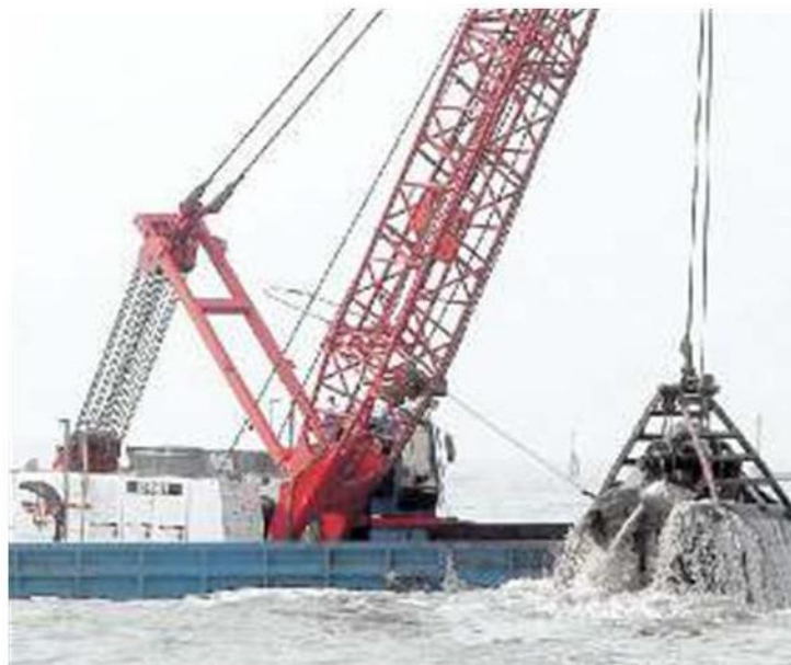
PORTO TOLLE La Busa di Scirocco sarà escavata
