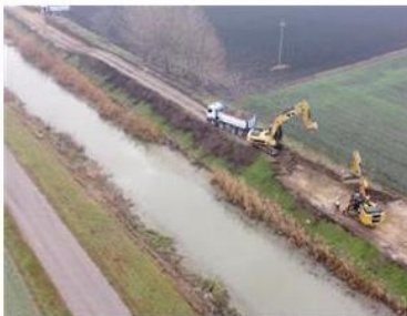
I lavori di sistemazione della sponda dell'Emissario ripresi dal drone
