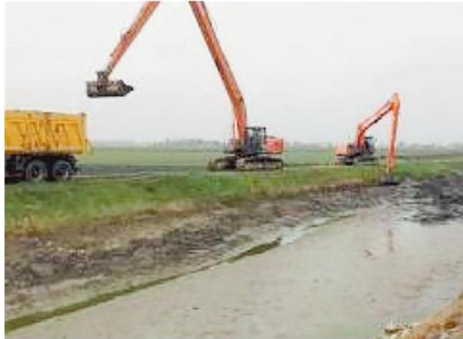
I lavori di scavo del canale Altipiano, lungo 22 chilometri
