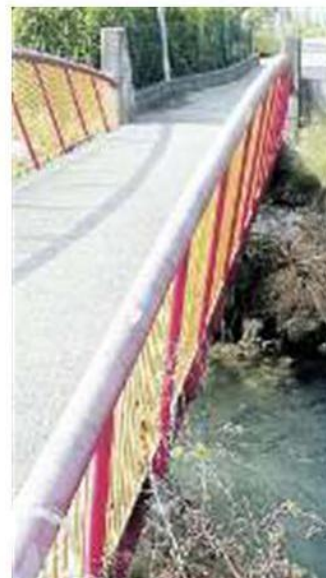
IN CORSO I lavori al ponte
