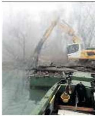
LUNGO IL BRENTA I lavori di pulizia degli argini
