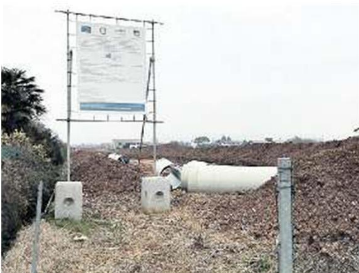
VIABILITÀ I lavori a Trevignano e sopra l'incrocio sulla Feltrina
