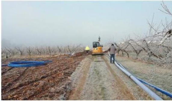
Lavori di posa della tubazione Pead
