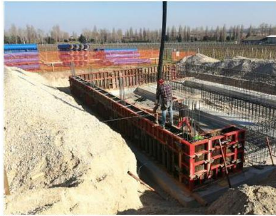
Lavori per la costruzione della centrale di pompaggio FOTOFECORA
