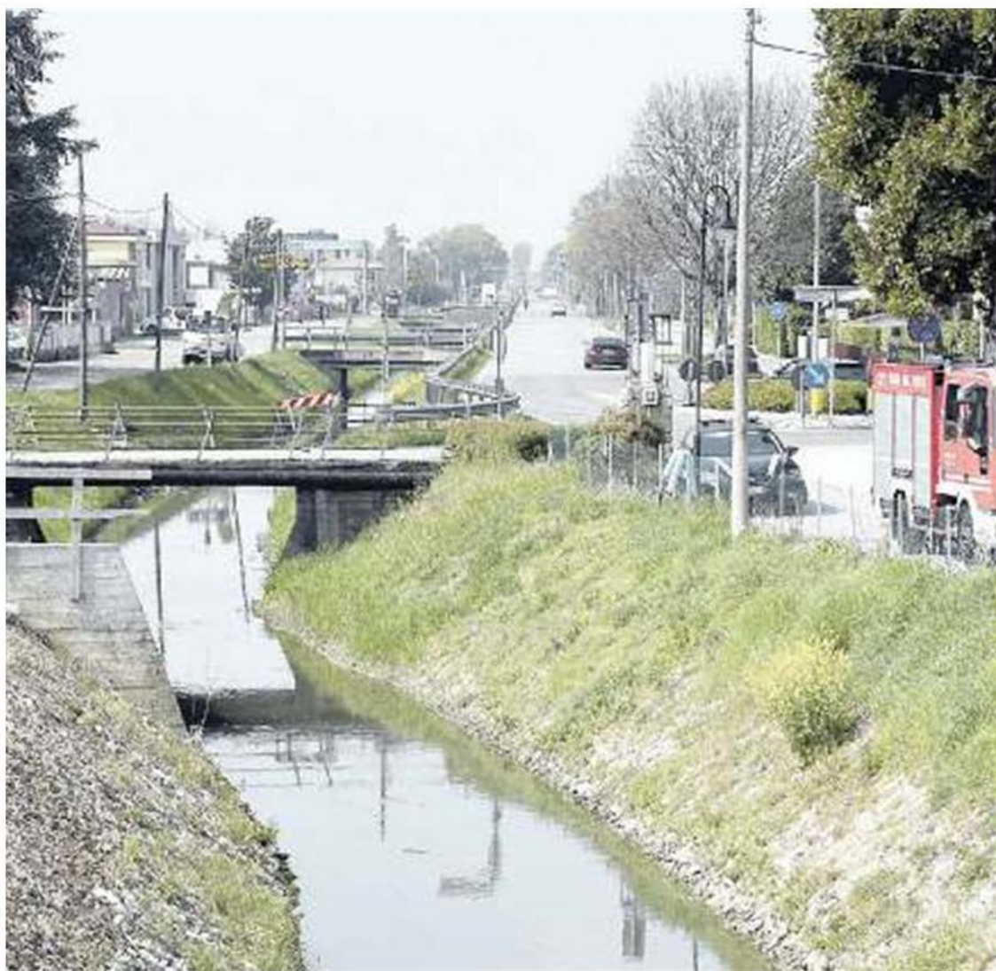
IL CANALE Una parte del corso d'acqua inquinato dallo sversamento di idrocarburi
