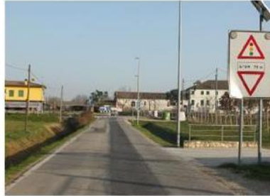
La strada che sarà interessata dai lavori per 45 giorni. L.A.MAZ.
