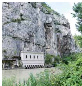
La Presa di Sciorne, realizzata fra il 1906 e il 1914 da dove si preleva l'acqua dell'Adige
