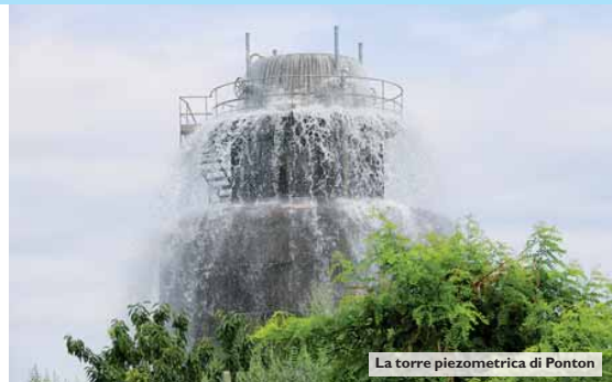
La torre piezometrica di Ponton
