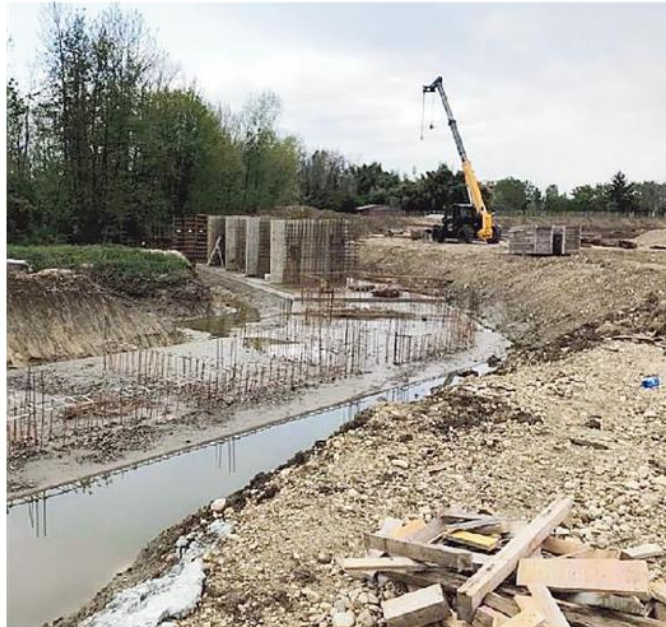
Il cantiere per la realizzazione della cassa di espansione
