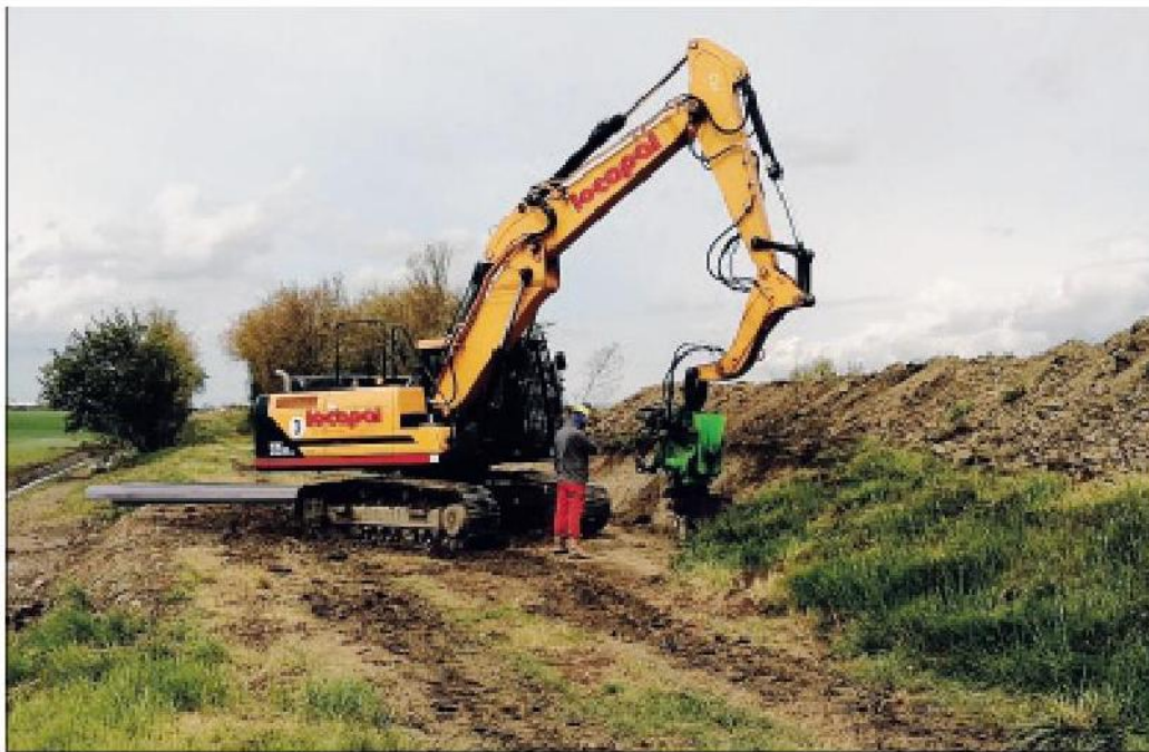
Lavori di bonifica sul Collettore padano
