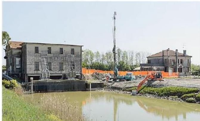
Il cantiere per la costruzione del nuovo sifone a Staffolo
