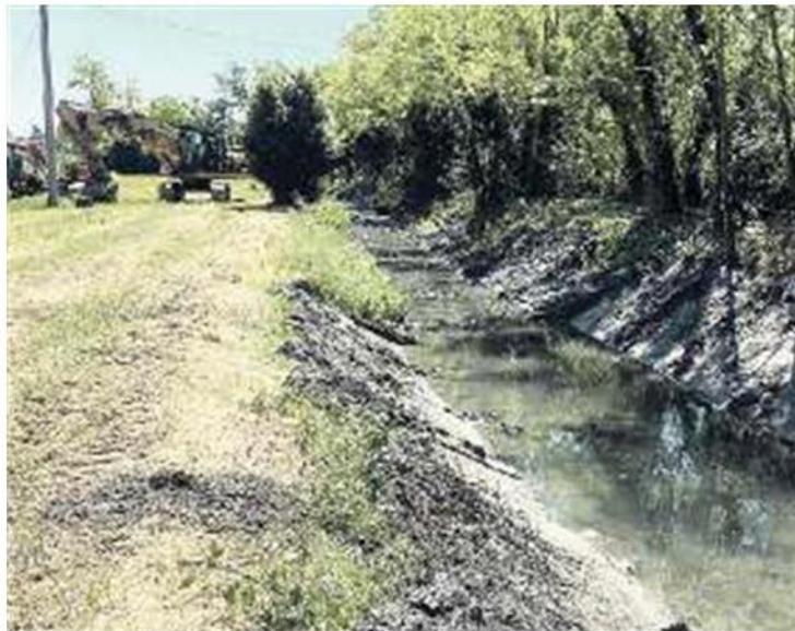
LAVORI IN CORSO Saranno messi in sicurezza gli argini in via Campagna Bassa, ai confini con la frazione di Mezzavia
