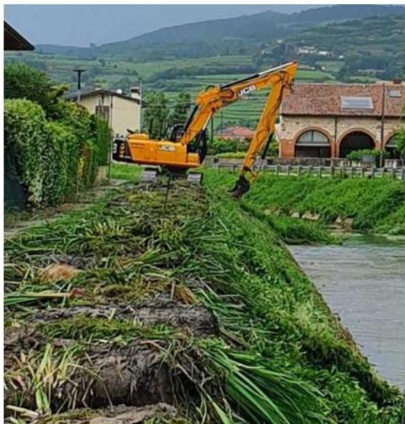
Ruspa al lavoro sull'argine del Tramigna a Soave
