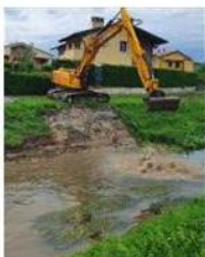
Messa in sicurezza del Tramigna
