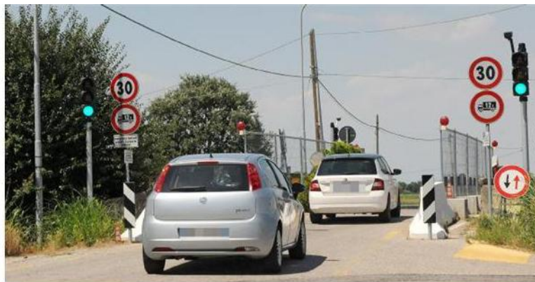
Il vecchio ponte sulla Fossa Maestra regolato da semaforo e con transito a senso unico alternato
