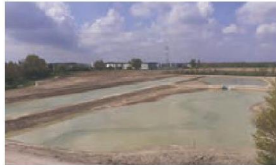
Realizzazione dell'area umida in Comune di Dolo
