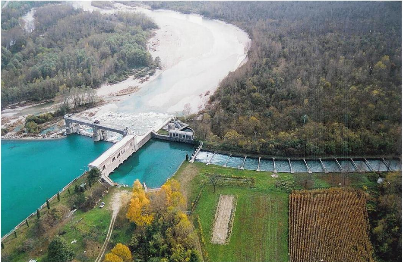
La presa di Fener sul Piave con il canale Brentella che alimenta gran parte del reticolo idraulico della Marca trevigiana
