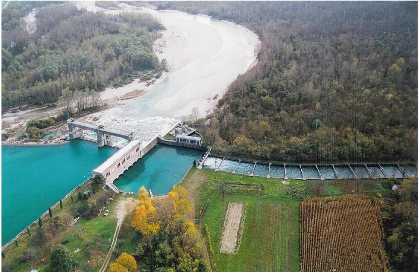
La presa di Fener sul Piave con il canale Brentella che alimenta gran parte del reticolo idraulico della Marca trevigiana
