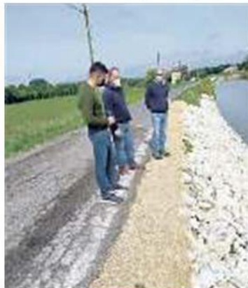
BENTIVOGLIO I lavori eseguiti
