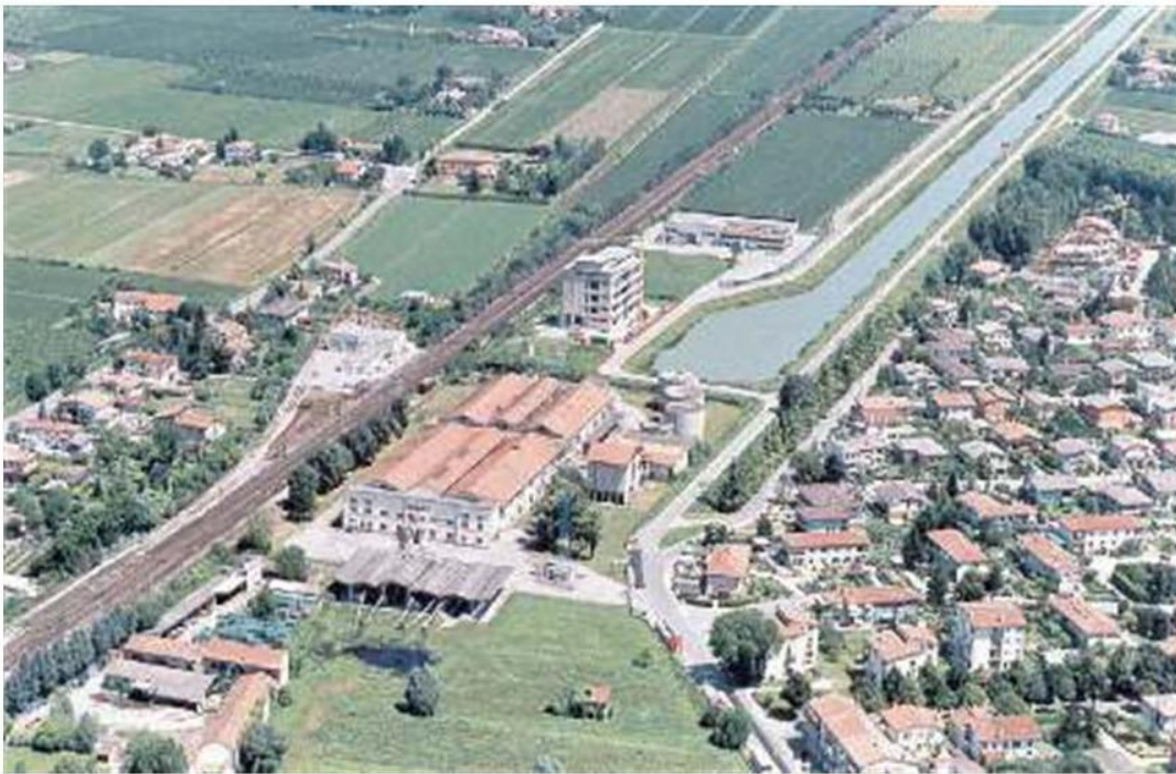
IN TRASFORMAZIONE L'area di Porta Nord a San Donà è oggetto di importanti investimenti
