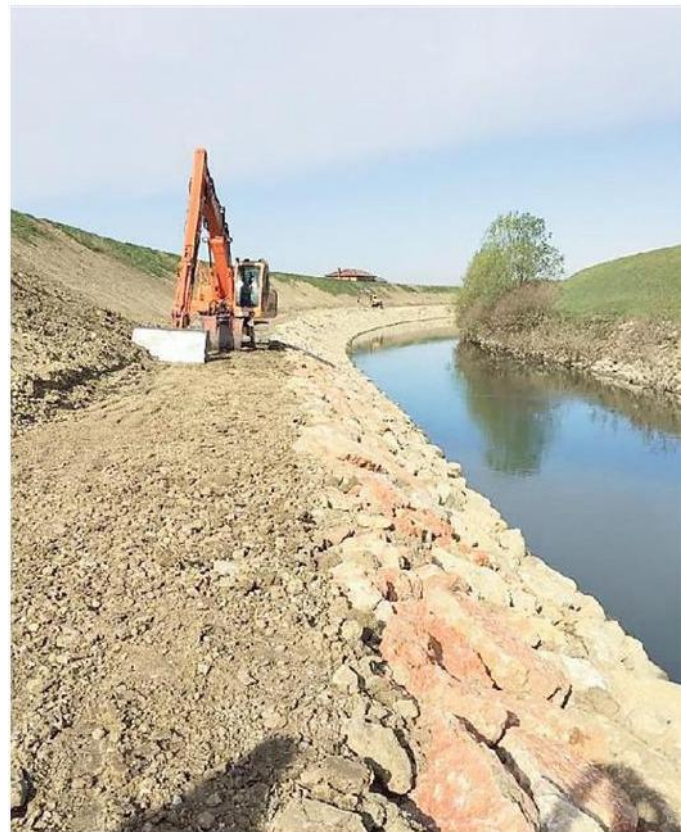
La messa in sicurezza degli argini del Monticano ad Albano di Motta
