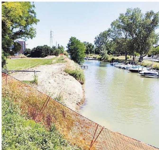
Il cantiere sull'Osellino all'altezza del ponte di via Pertini
