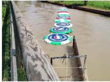
L'impianto Un sistema di galleggianti convoglia la plastica in una rete
