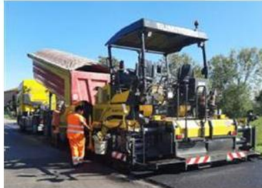
Asfaltature Il Comune sistemerà una serie di strade e marciapiedi. ARCHIVIO
