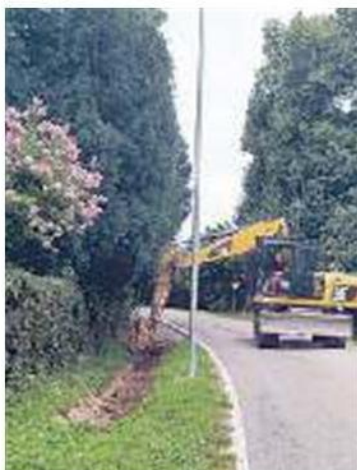
CONTRO LE ALLUVIONI Pulizia dei fossi
