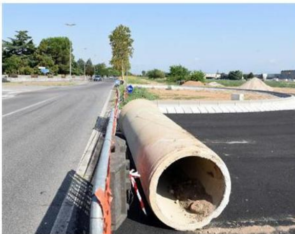
Preparativi del cantiere per il completamento della rotatoria di Raldon, già realizzata per metà. Foto: n. n. n.
