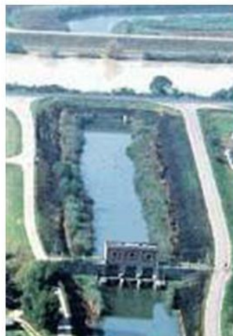
QUATTRO SECOLI Una veduta dall'alto del luogo d'intervento
