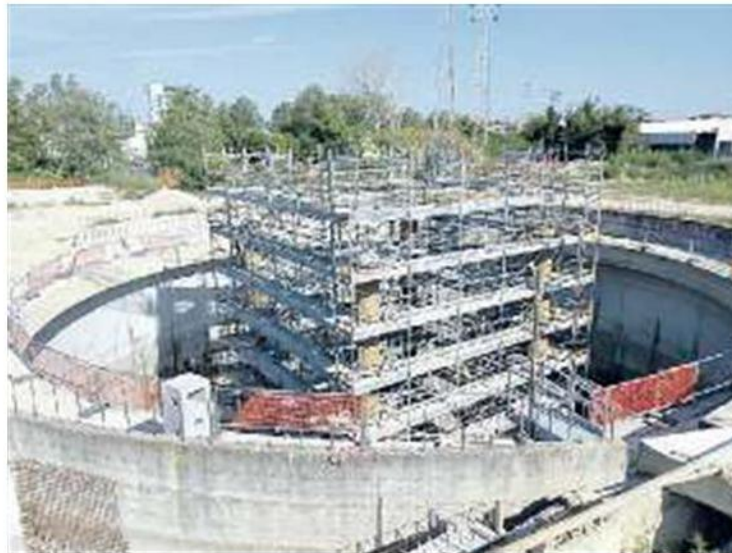
SICUREZZA Il nuovo impianto idrovoro di Veritas in via di realizzazione in via Torino garantirà la sicurezza idraulica
